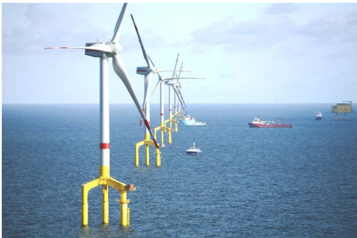
*Fondations et turbines de plusieurs mégawatts pour éoliennes en mer cofinancées par le PEER installées sur le site Bard I dans la mer du Nord, en Allemagne.*
