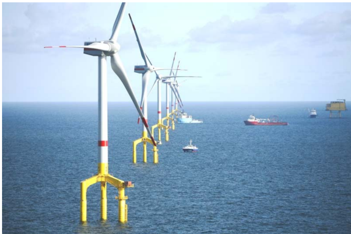
Мултимегаватови турбини и разположени в морето фундаментни конструкции, съфинансирани от ЕЕПВ, които са инсталирани на обекта Vard I в германската акватория на Северно море
