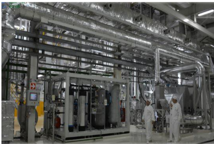
Фигура 1 — Съоръжение за плазмено топене
