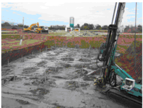
Travaux d'excavation et de battage des pieux
