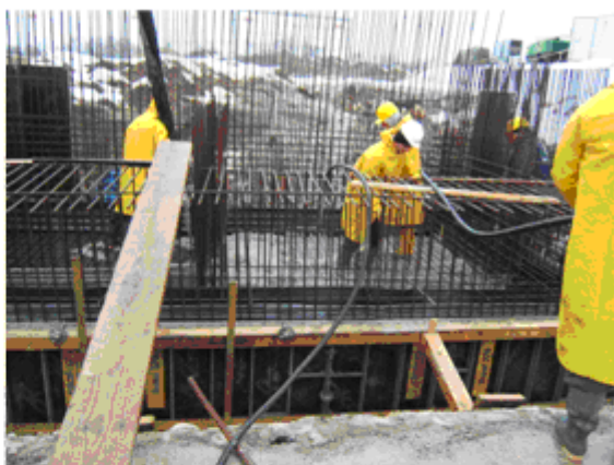
Coulage du béton dans les fondations
