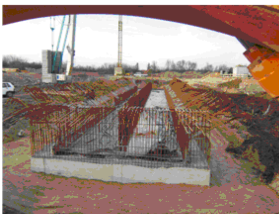
Réalisation des fondations
