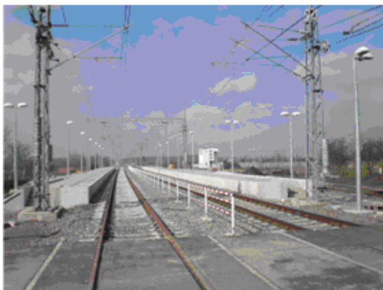
Gare de Deletovci, vue ouest
