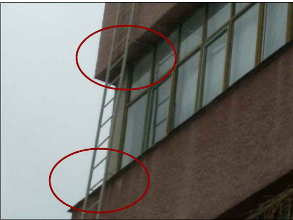
демантиране на захващане на металната стълба към дограмата и закрепване към фасадата
